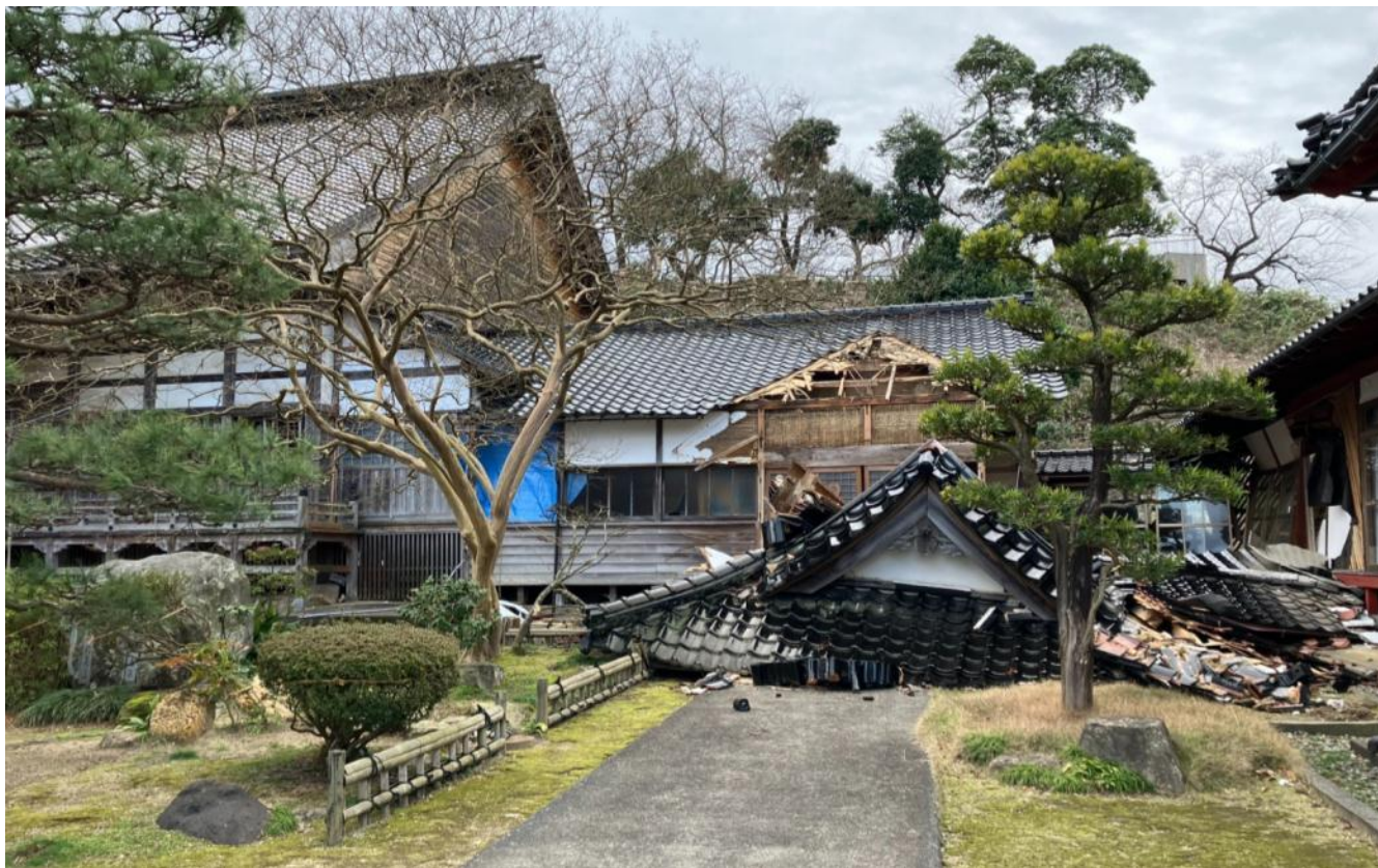
六地藏が山門の下敷き。手前は倒れた徳本名号塔。
