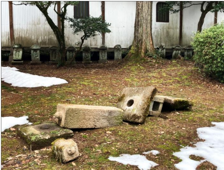
富山県射水市橋下条の高野山真言宗薬勝寺 2月9日 滝本撮影 聖天堂前の灯籠が倒壊している。西国三十三ヶ所観音も数体が後ろへ倒れかかっている。
