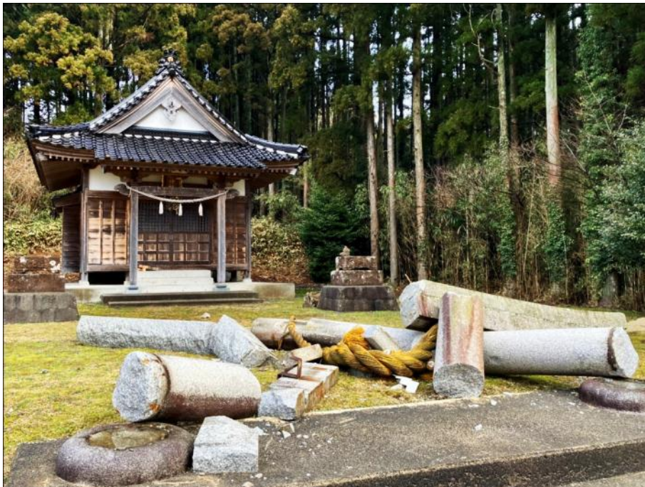
石川県志賀町豊後名の八幡神社 2月11日 滝本撮影 鳥居が倒壊。狛犬は2体共に台座から転落している。
