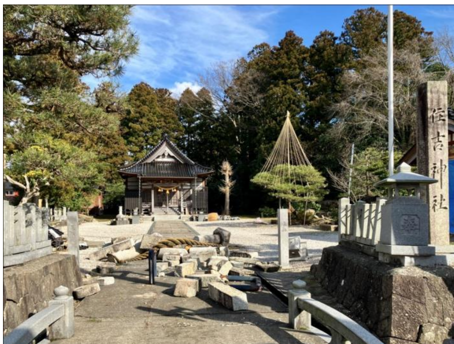
石川県七尾市田鶴浜町の住吉神社 2月11日 滝本撮影 鳥居や灯籠が倒壊、狛犬も台座から転落している。
