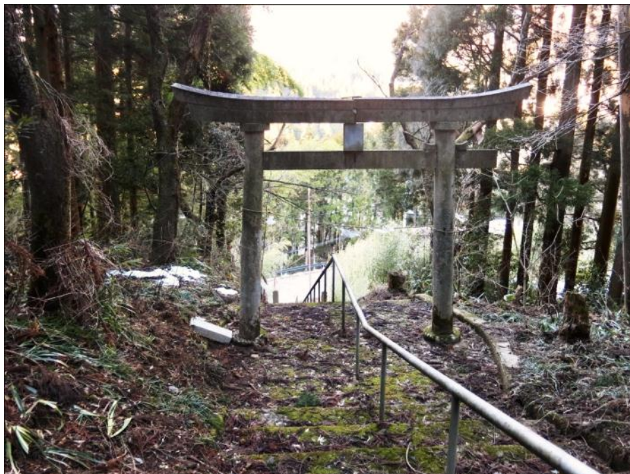
富山県富山市吉野の蔵王社 2月13日 松井撮影 鳥居の木鼻が落ちている。
