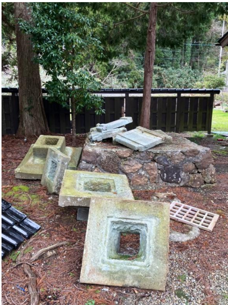
倒壊した五重塔
