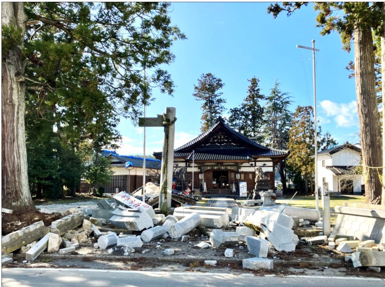
石川県穴水町大町の穴水大宮 2月17日 滝本撮影 社号標柱、鳥居、灯籠、玉垣などが倒壊散乱している。
