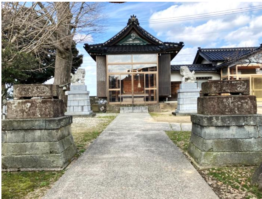
石川県金沢市南森本町の住吉神社 2月14日 滝本撮影 玉垣が倒壊、狛犬が転落しており、境内の隅に置かれている。
