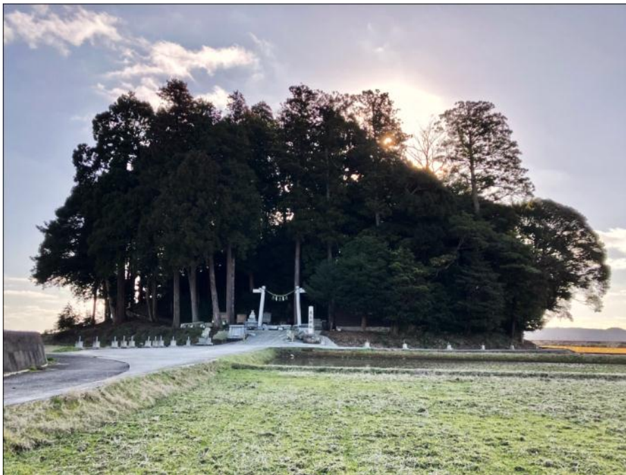
石川県穴水町鹿島の鹿島神社 2月17日 滝本撮影 鳥居上部が崩落。灯籠、狛犬なども倒壊している。
