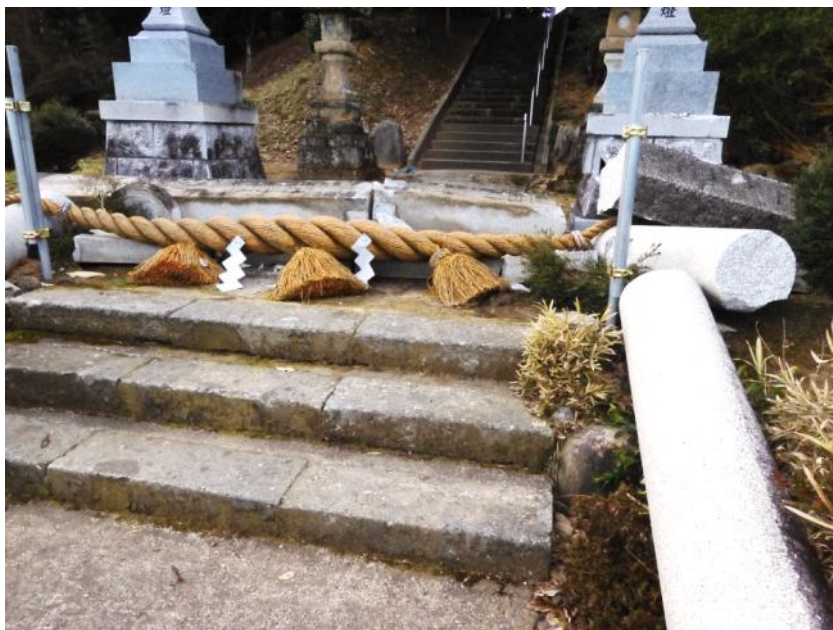
富山県小矢部市松尾の松尾神社 2月18日 尾田撮影 鳥居と奥殿前の灯籠が倒壊している。
